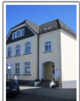
Kindergarten an der Rochollstraße
