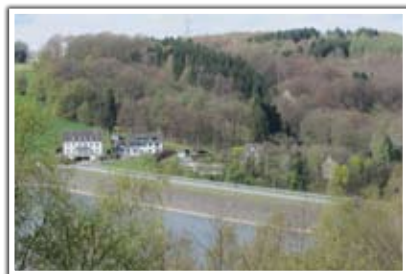
Damm der Wuppertalsperre unterhalb Wallenberg
